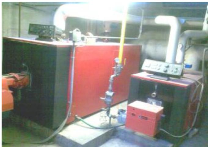
Gli ambienti vengono riscaldati mediante radiatori in ogni singolo ambiente. Il rendimento energetico istantaneo globale viene calcolato considerando il rendimento di combustione misurato del generatore di calore ed i rendimenti da norme UNI per terminali, regolazione e distribuzione.
